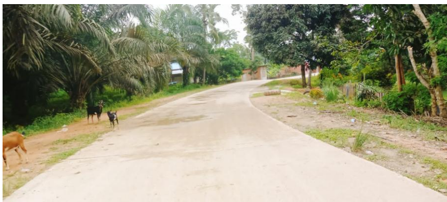
Sumber : Dokumentasi Penulis
