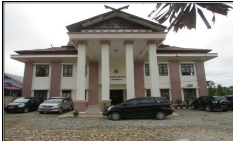
Gambar 1.2 Gedung Pengadilan Agama Bangko Baru
