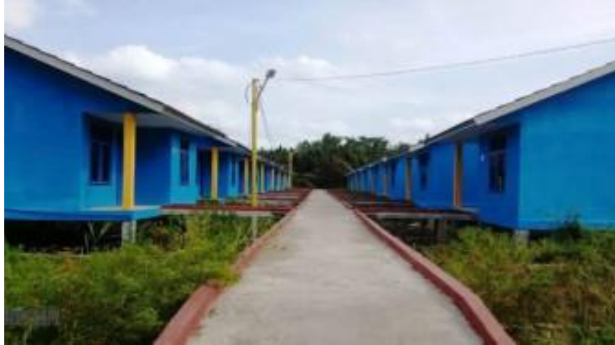
Perumahan Khusus Nelayan Kecamatan Nipah Panjang
