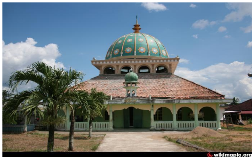
Gambar 4.10 Masjid Nurul Islam Sebelum di Renovasi
