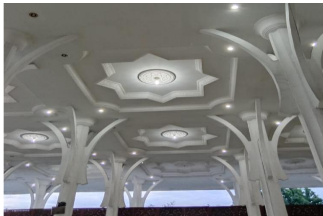
Gambar 4.29 Gambar Plafon Masjid
