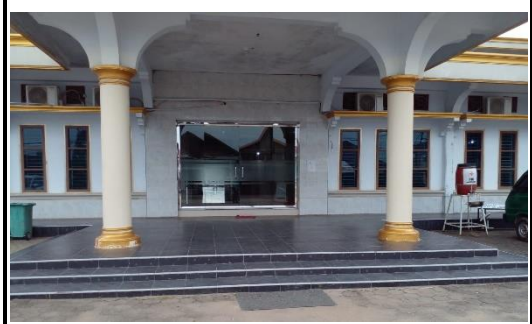
Gambar 19. Teras dan Pintu Utama
