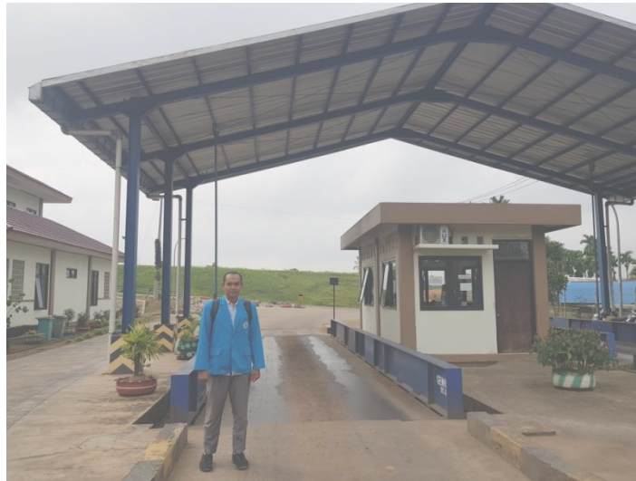
Foto Jembatan Timbang TPA Talang Gulo
