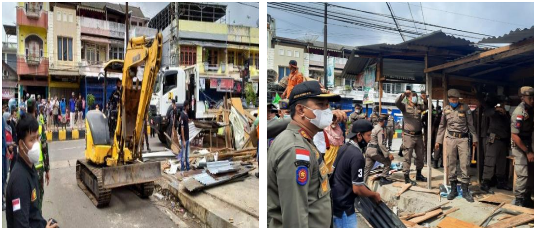
Gambar 4.2 Penertiban Bangunan di Pasar Kito
