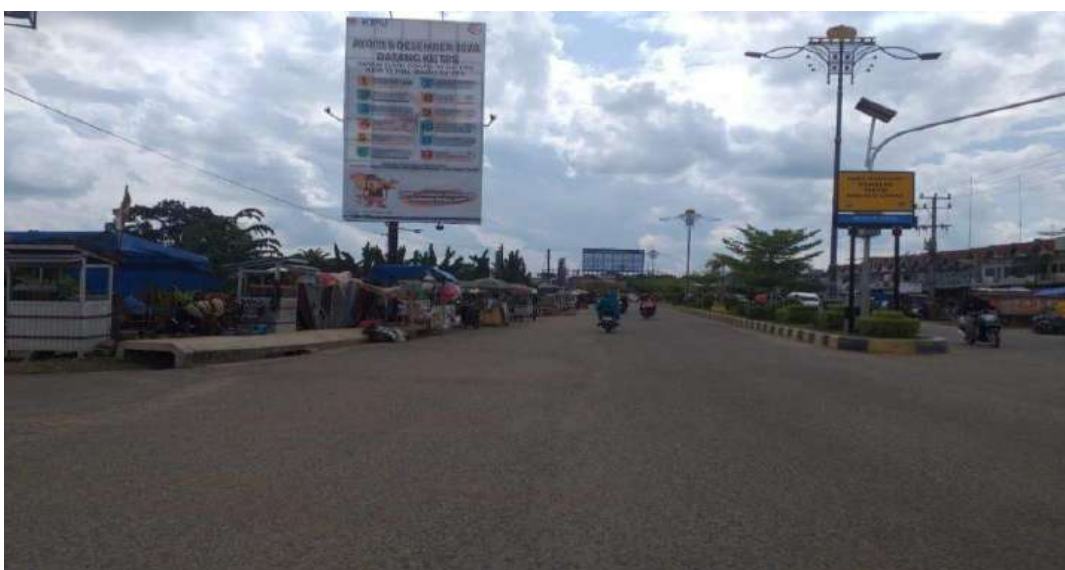
Gambar 4.2 Kondisi Jalan di Kecamatan Rimbo Bujang
