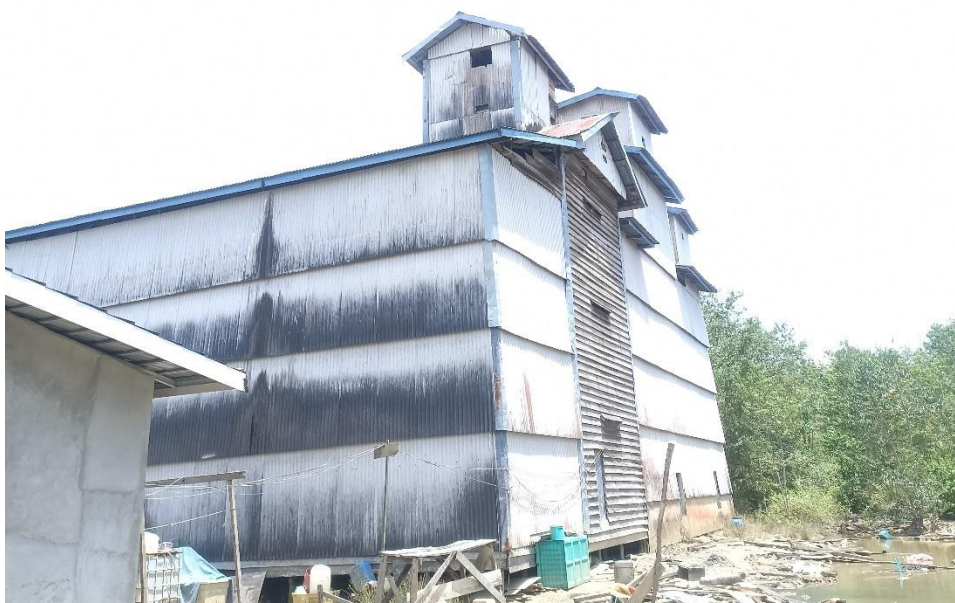
Bentuk Bangunan Gedung Sarang Burung Walet Bapak H. Nakong.
