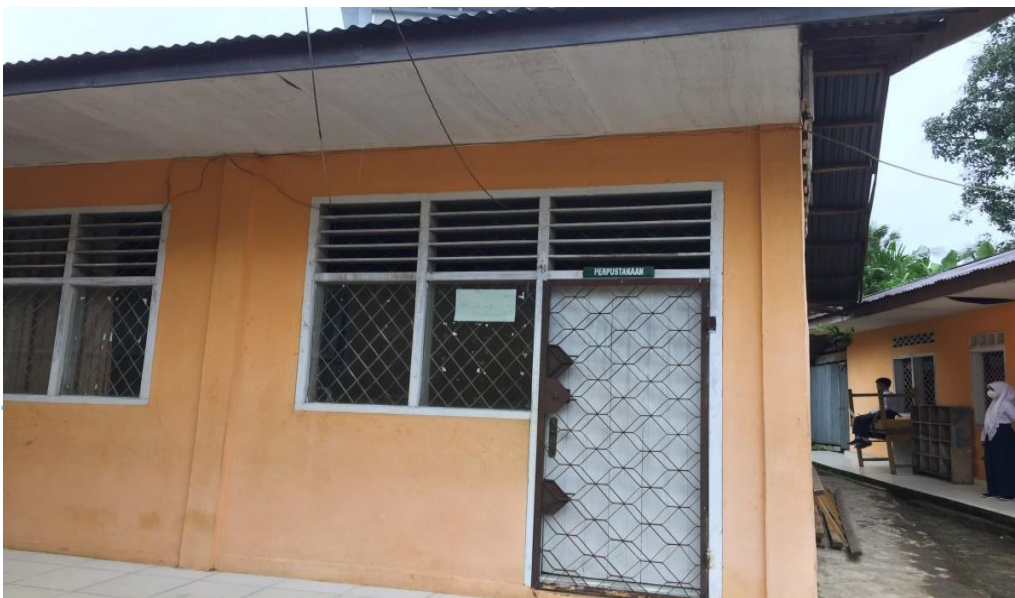
Gedung Perpustakaan MTs Tarbiyah Islamiyah Kota Jambi
