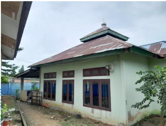
Fasilitas Musholah SMPN 30 Muaro Jambi
