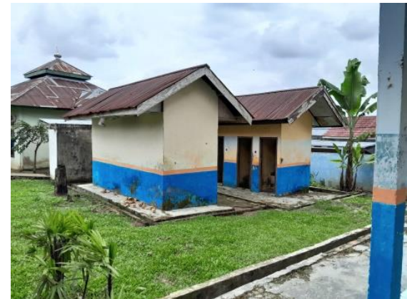
Fasilitas WC SMPN 30 Muaro Jambi
