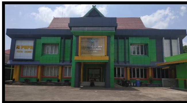
Gambar 4.3 Gedung Belakang Kantor Dinas PUPR Kota Jambi
